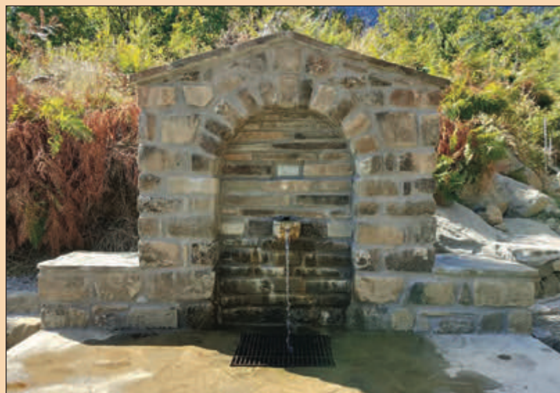
Η ανακατασκευασμένη βρύση
