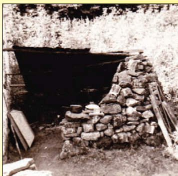
Υπαίθριο μαγειριό στο Παλιοζωγλόπι το 1964. (Φωτ. Λ. Γριβέλλα)
