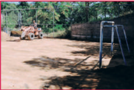
Το γήπεδο 5x5 επισκευάζεται
