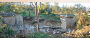
Η κατεστραμμένη από τον "Ιανό" γέφυρα στις "Σκιάς το ρέμα"
